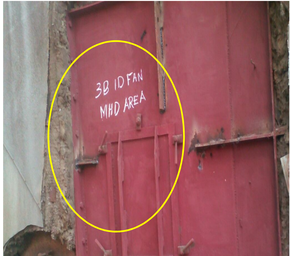
ID FAN CASING: AFTER
